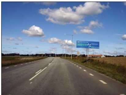
Anslutningsväg till cirkulationsplatsen från Gårdstånga, väg 104.
