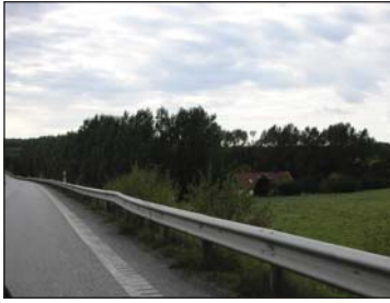
Påfartsväg mot Lund, väg E22 väster om trafikplats Gårdstånga.
