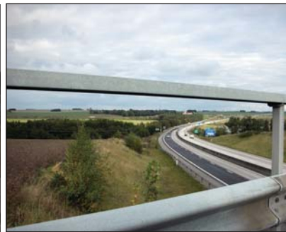
Bron över väg E22, väg 940 (Igelösavägen). Utsikt över cirkulationsplatsen i nordost.
