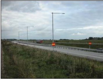
På- och avfartsvägar väg E22 öster om trafikplats Gårdstånga.
